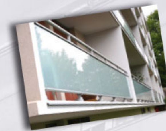
Garde-corps balcons Le Clémenceau (Saint Genis Laval)
